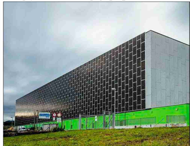
Aussenansicht des greenDatacenters
