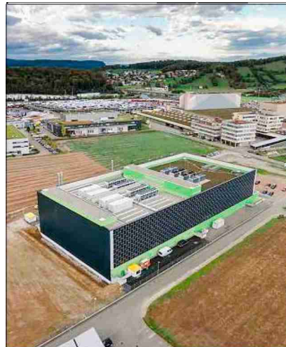
greenDatacenter von oben Bild: zVg
