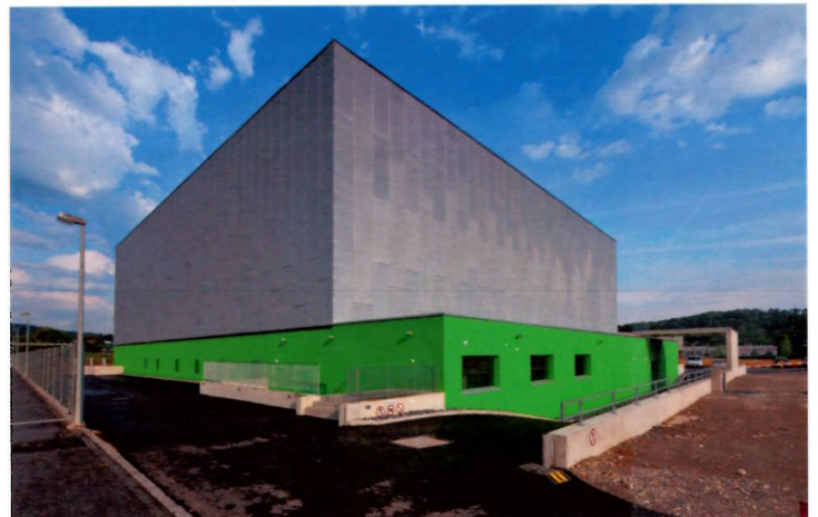
Green Datacenter SA
