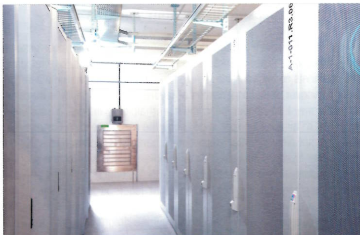
L'utilisation du courant continu est spécialement intéressante en corrélation avec les sources d'énergies alternatives et renouvelables.
