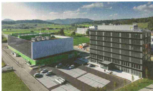
Auch als Service: Rechenzentrum von Green.ch.
