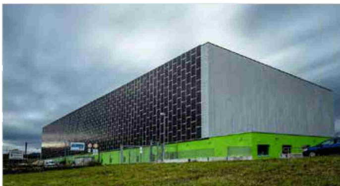
Das Green Datacenter in Lupfig ist ein Hochleistungsrechenzentrum, das auf modernste Sicherheitstechnik setzt.
