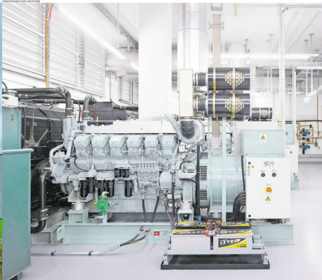
Rechenzentrum von Green in Lupfig (AG). Fällt der Strom aus, sorgen Generatoren mit 45 000 PS dafür, dass die Server weiterlaufen.
