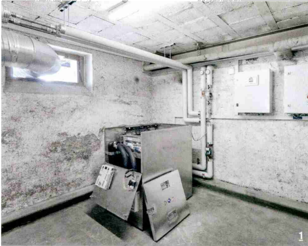
1 Die von IWB installierte Serverheizung beansprucht weniger als 1 m 3 Platz.
